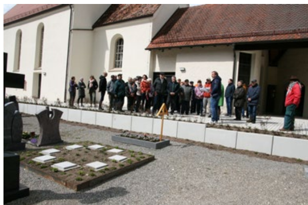
Die Sanierungsarbeiten im Friedhof Zwiefalten fanden große Zustimmung
