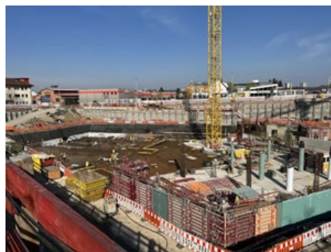
Blick in die Baugrube; Quelle: Landratsamt Reutlingen
